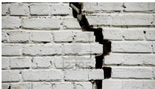
3.2. ábra: Habarcs hézagban és téglán át futó függőleges törésvonal
