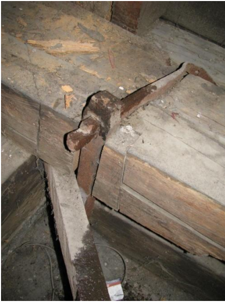
10. ábra Talpszelemen lekötése
