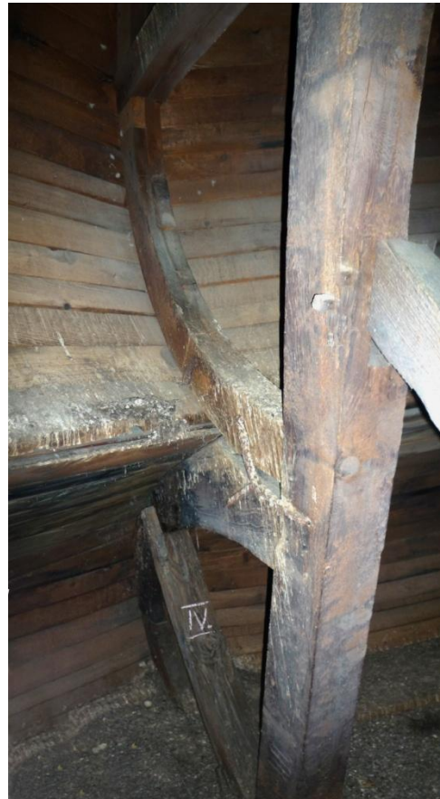
13. ábra A toronysisak felső zárt részének ramonádja
