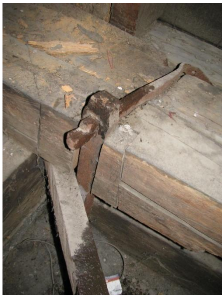
10. ábra Talpszelemen lekötése
