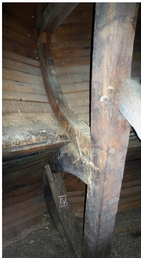
13. ábra A toronysisak felső zárt részének ramonádja
