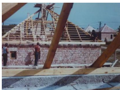
Épül a kockaház az árvíz után
