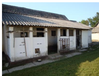
K33 disznóólja vasbeton vázzal
