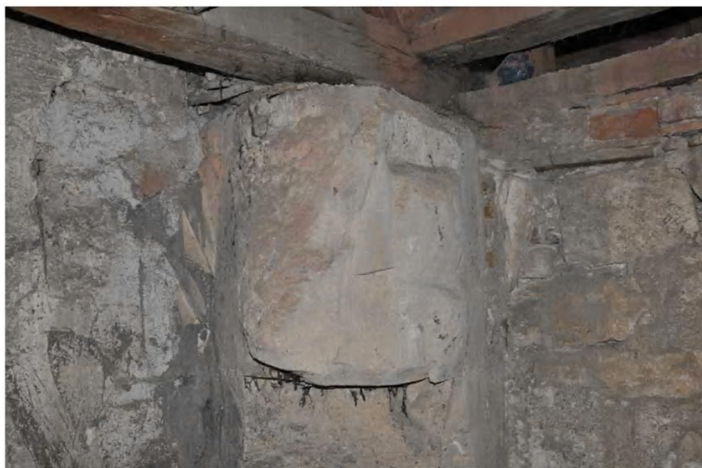
22. kép: Gótikus bordaindítások a padlástérben
