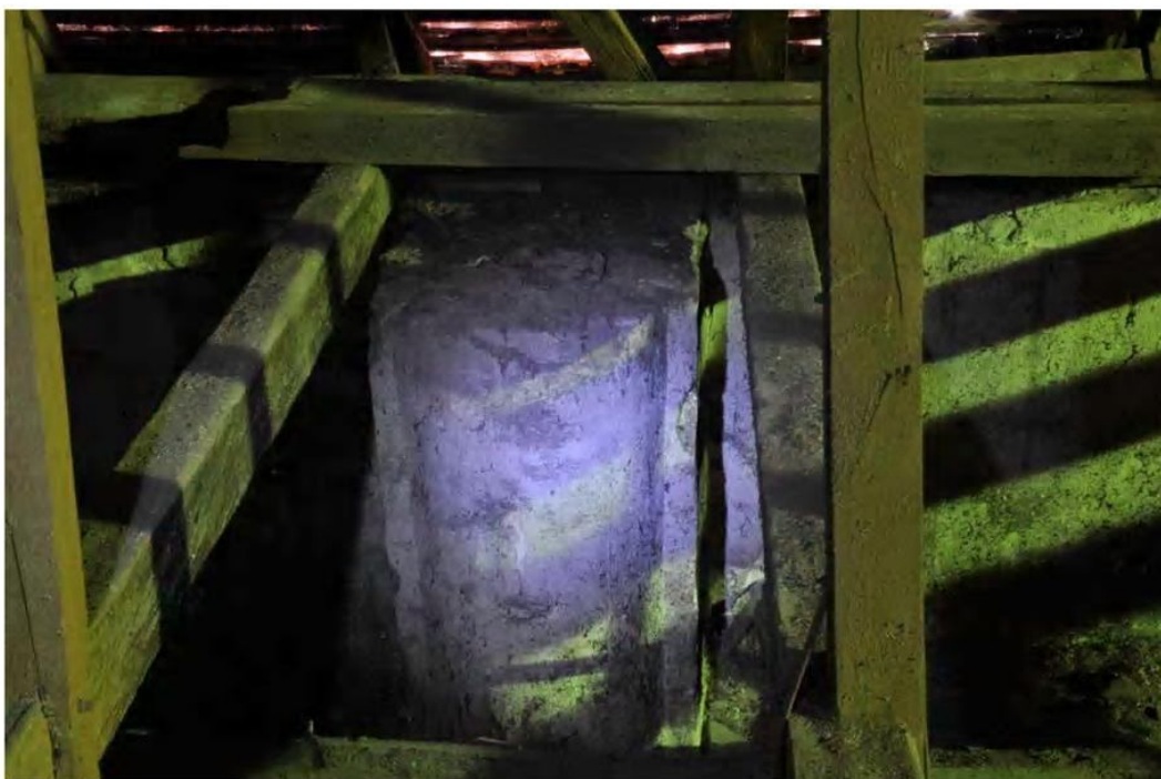
32. kép: Padlástérben látható gótikus támpillér
