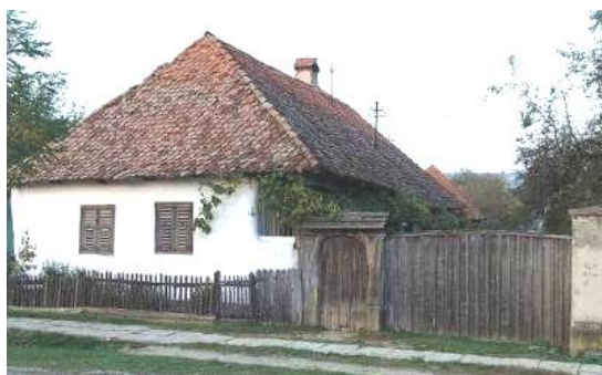
5. sz. ábra: Régi vargyasi ház bornákból építve, jellegzetes vargyasi gyalogkapuval Forrás: Sütő Olga fotója
