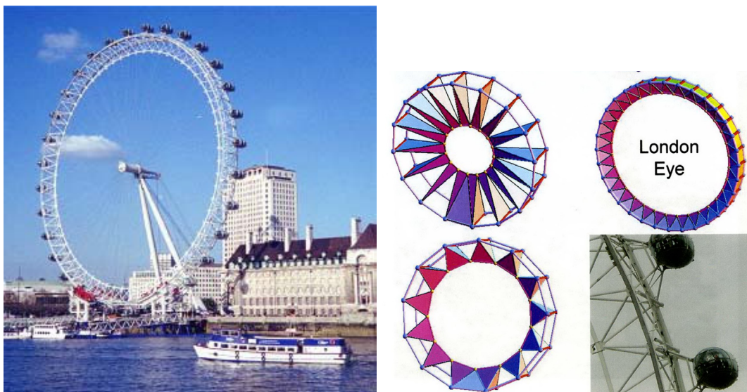
17.ábra. London Eye és tartószerkezete
