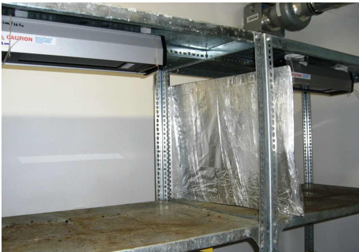
8. ábra: Az UV lámpák elhelyezése az állványon (fotó: SZABÓ A.)
