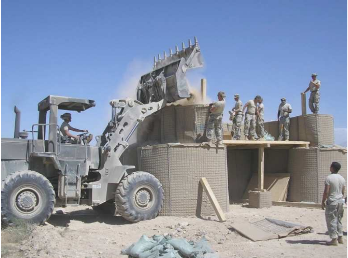
5. kép HESCO bástyák töltése egy táborban műszaki gép segítségével.
