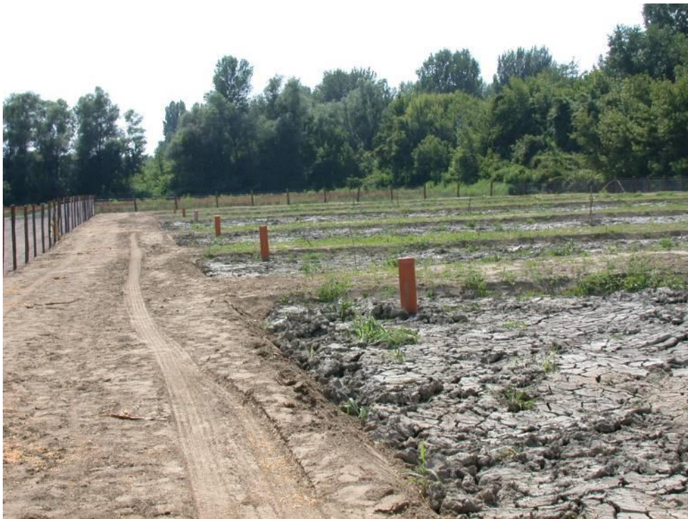
16 . ábra A kész kazetták és a figyelőkutak
