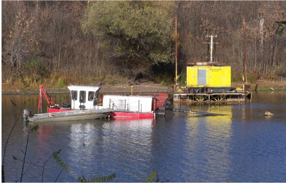
6. ábra Iszapkotrás a Mártélyi Tisza holtágon
