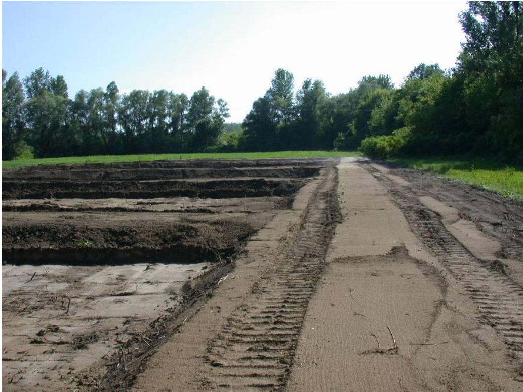
14 – 15 . ábra A kísérleti kazetta építése
