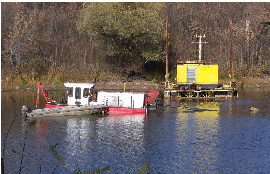
6. ábra Iszapkotrás a Mártélyi Tisza holtágon
