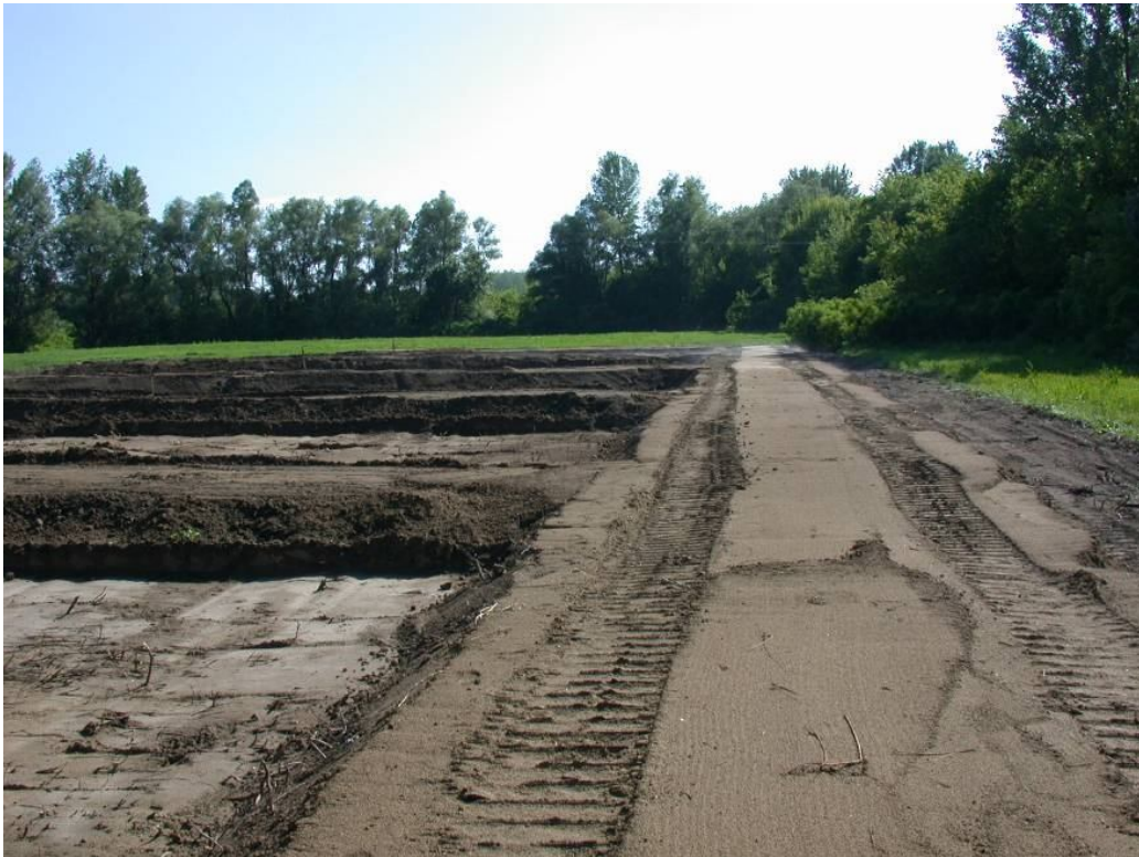
14 – 15 . ábra A kísérleti kazetta építése
