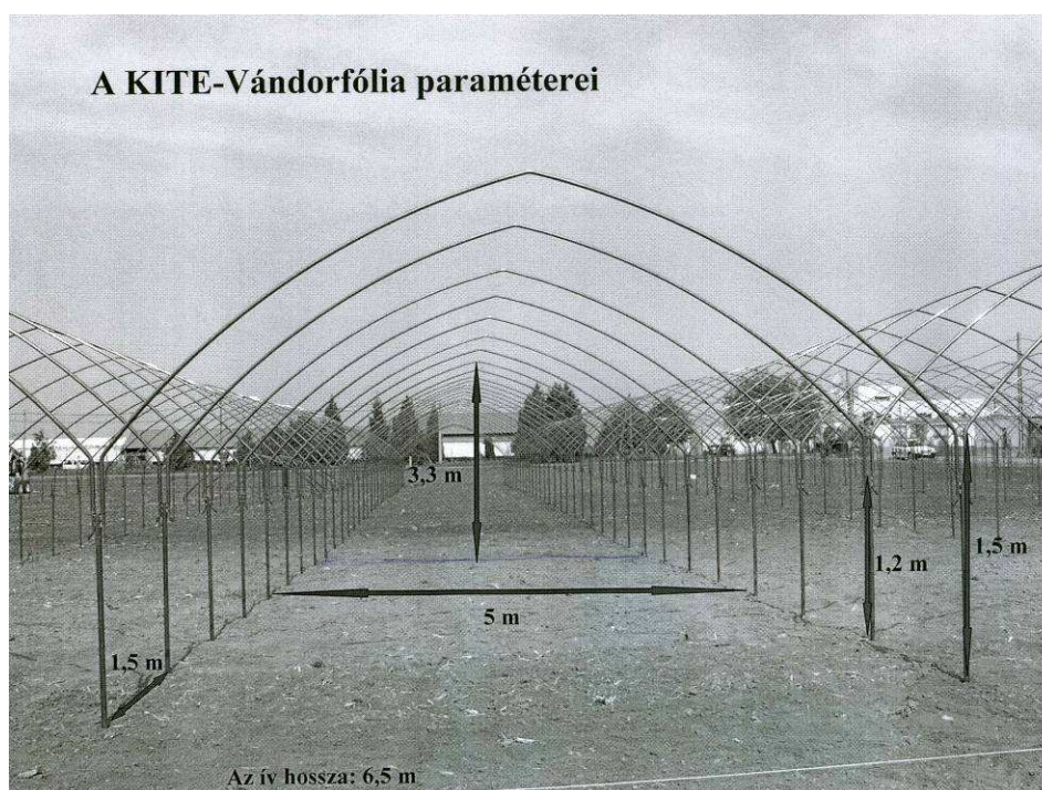
3. ábra: A KITE vándorfólia szerkezete
