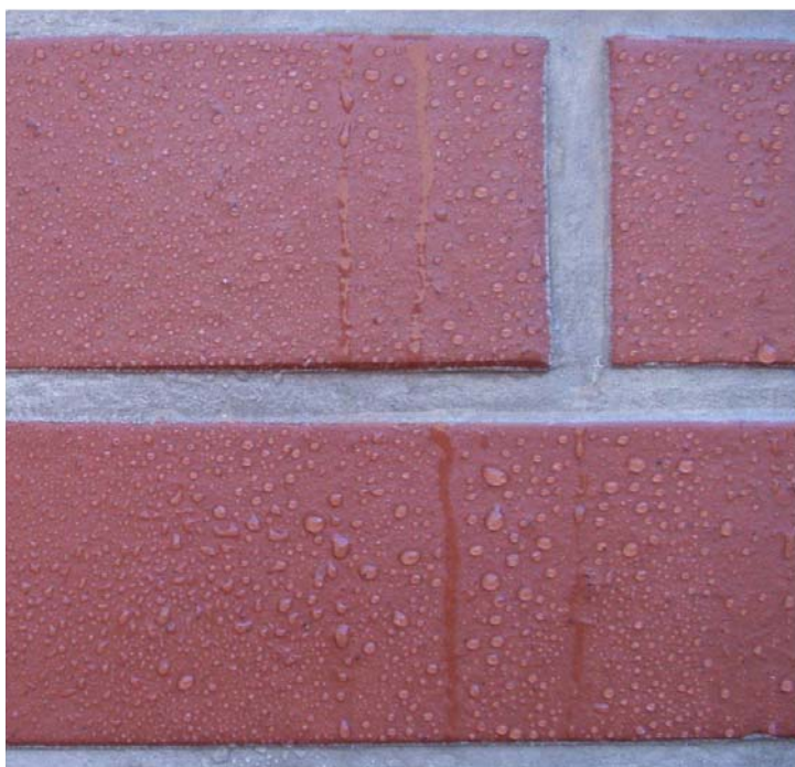
Impregnálással víztaszítóvá tett kerámiaburkolat
