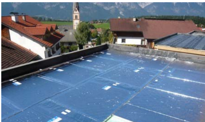
Tetőfödém hőszigetelése VIP lemezekkel
