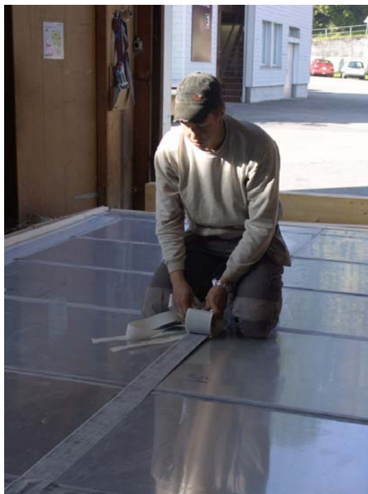
Belső tér szigetelése VIP lemezekkel
