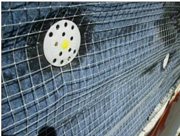
Hőszigetelő paplan rögzítése a falon
