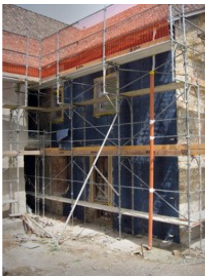
Épülethomlokzat hőszigetelése
