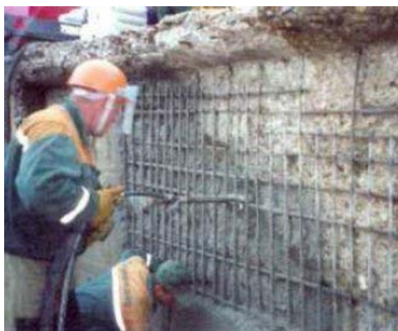
NanoCrete betonjavító habarcs és alkalmazása szerkezet megerősítésre
