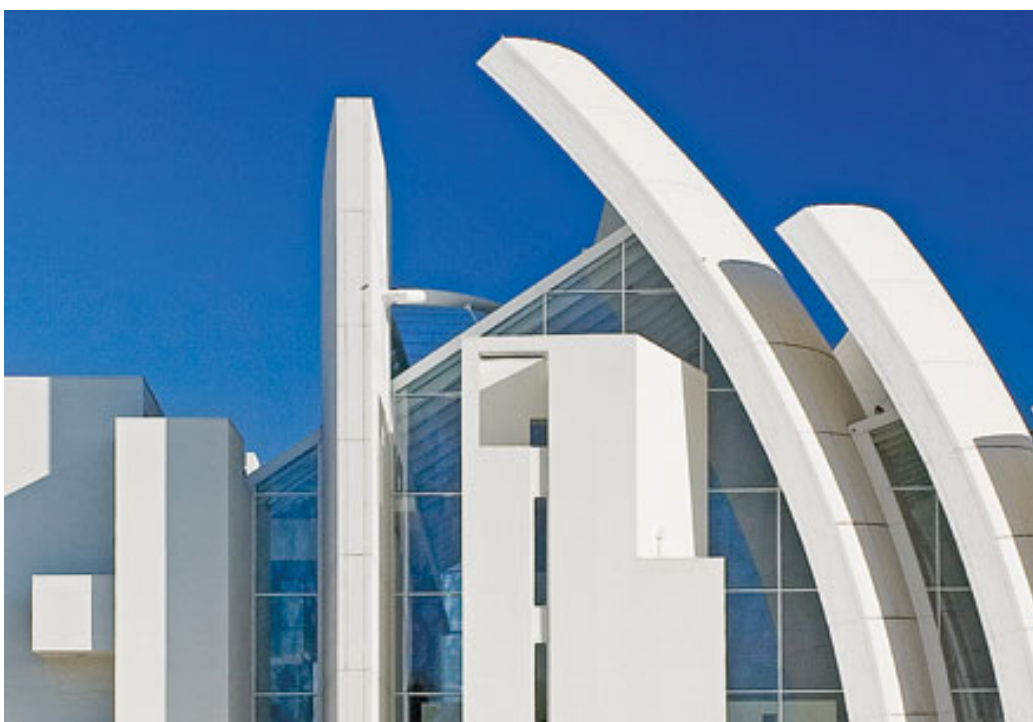
A jubileumi templom fotokatalitikus betonból előregyártott panelelemei
