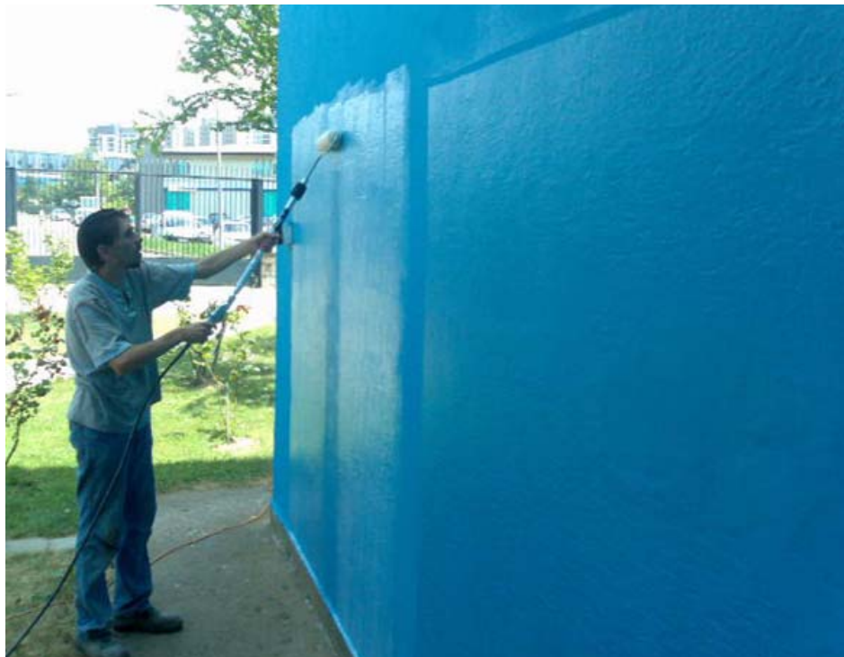
Falfelület szigetelése és hidrofobizálása
