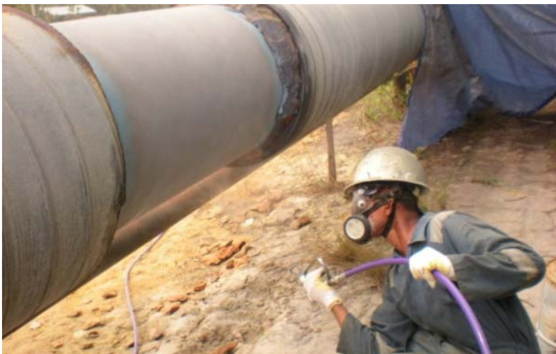
Nansulate Translucent bevonat alkalmazása az energiaiparban
