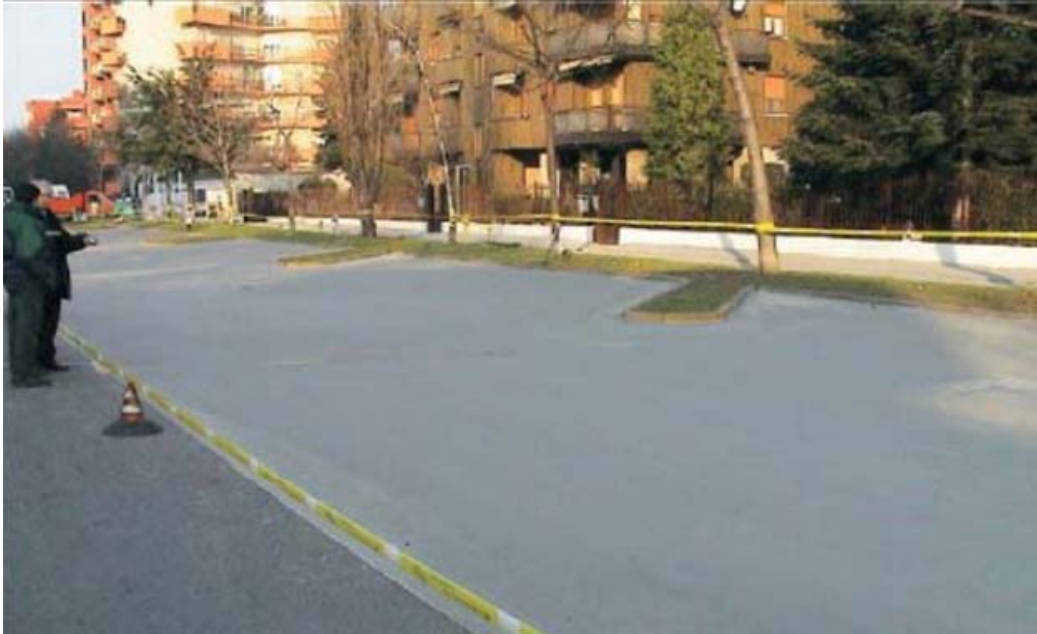
Önterülő betonnal készült, fotokatalitikus útfelület, Segrate (Olaszország)
