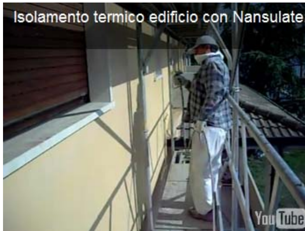
Nansulat bevonat felhordása a falfelületre
