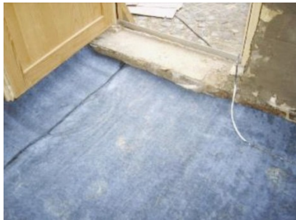
Aljzat és padló hőszigetelése
