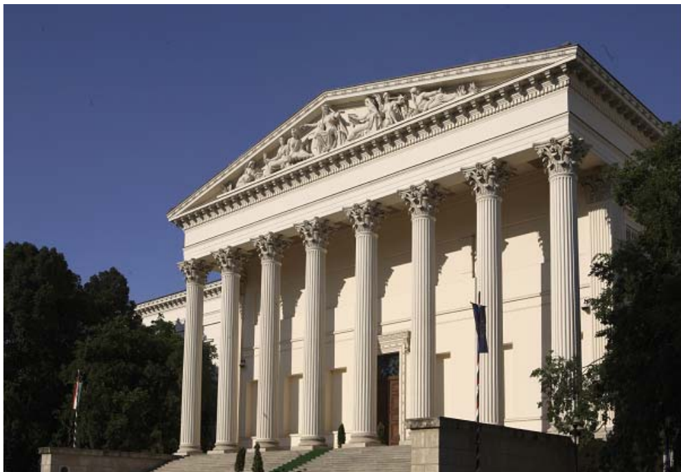
Épülethomlokzat Caparol CarboSol öntisztuló festékbevonattal
