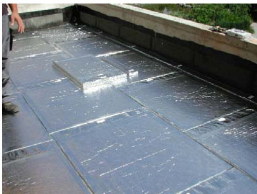
Tetőfödém hőszigetelése VIP lemezekkel
