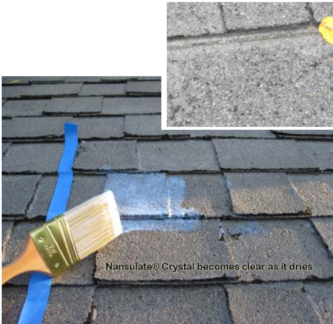
Bitumenes zsindely hidrofobizálása, felületkezeléssel
