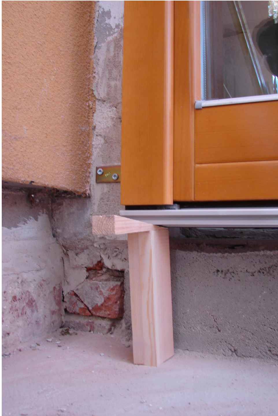
A nyílászáró pontos kiékelése alulról
