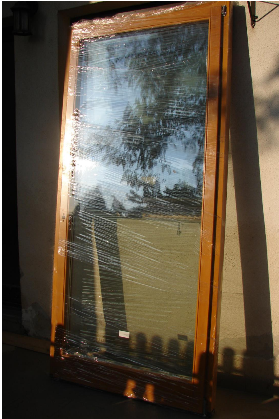
Az új nyílászárók előregyártott, 2x-es üvegezésű, korszerű szerkezetek
