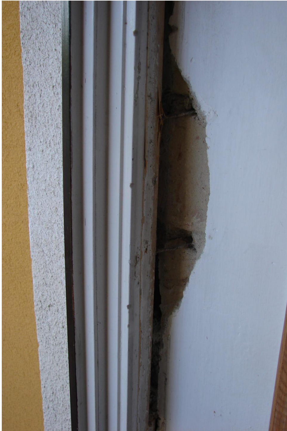
A régi nyílászáró becsatlakozása a falazatba
