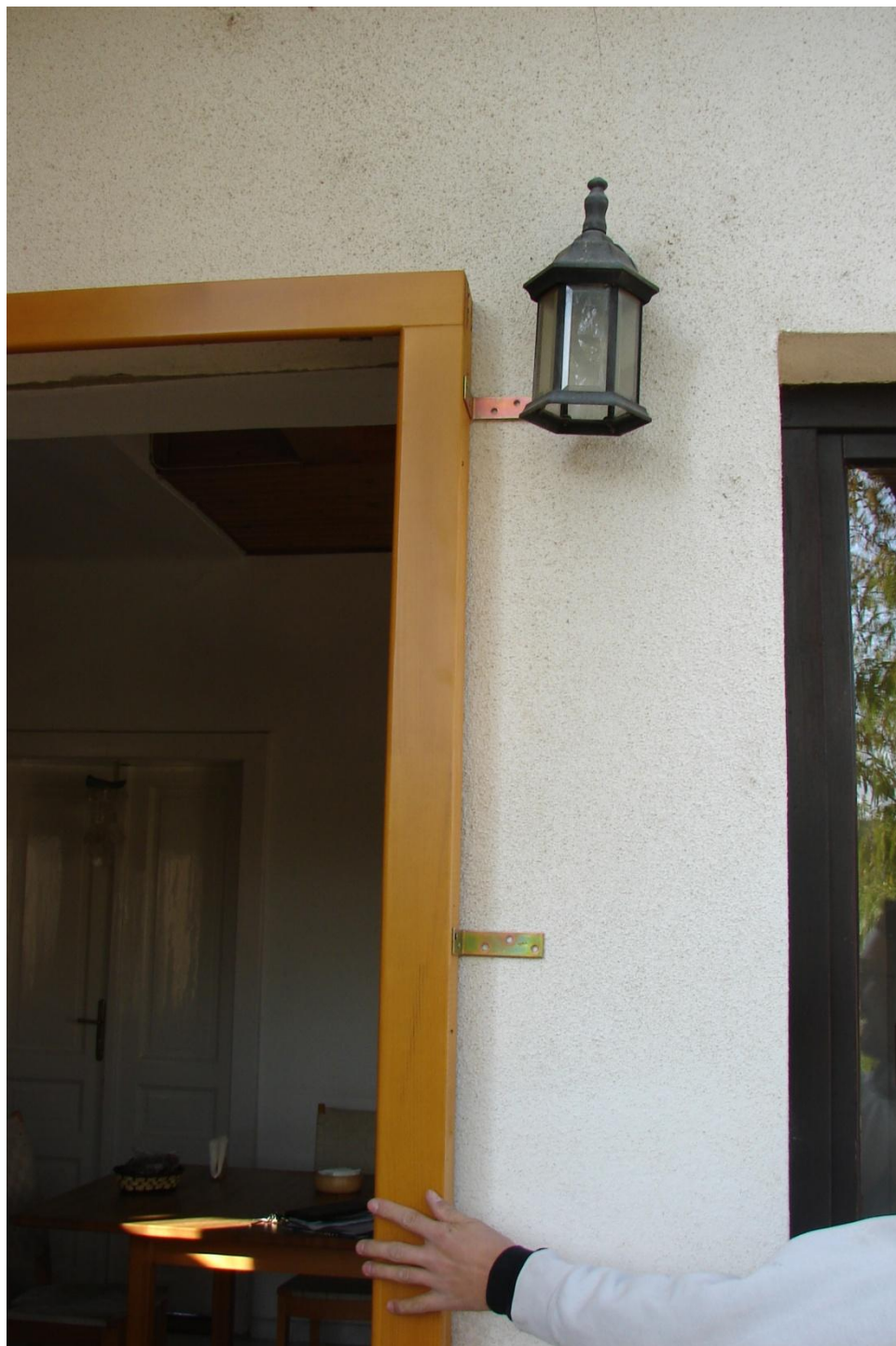
A tartóprofilokkal felszerelt nyílászáró beemelése a falnyílásba
