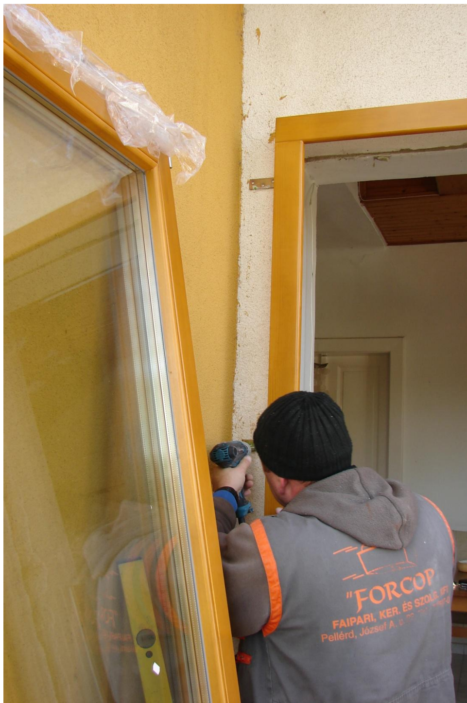
A tartóprofilok felfúrása a falazatba
