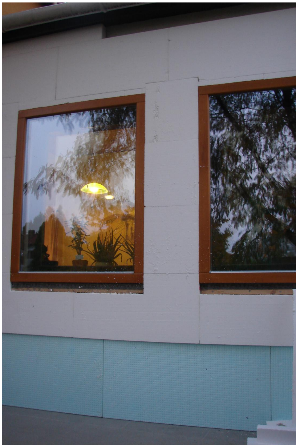
Hőszigetelő táblák felhelyezése
