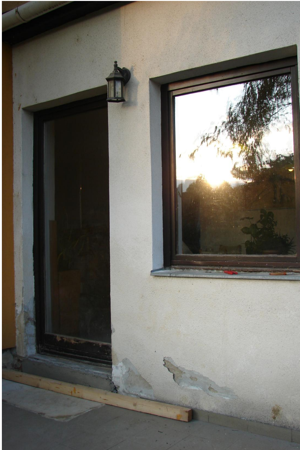
Az épületből kibontásra kerülnek a régi nyílászárók
