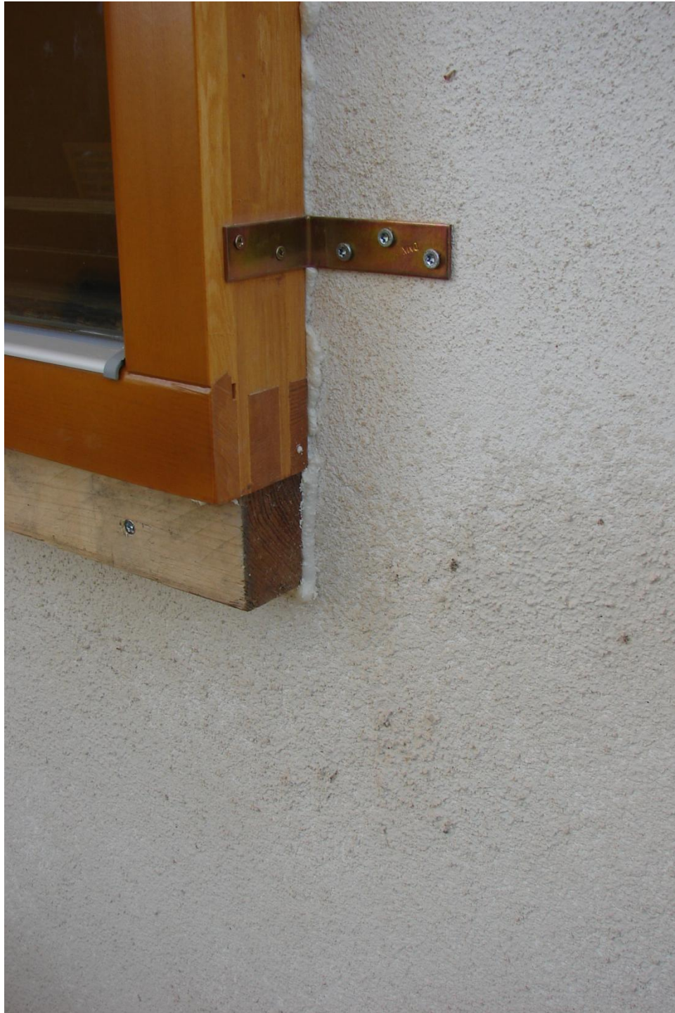
Az ablakok alátámasztása becsavarozott falécekkel
