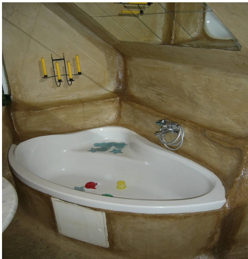
17 sz. kép Dekorbetonból készült vizesblokk burkolat
