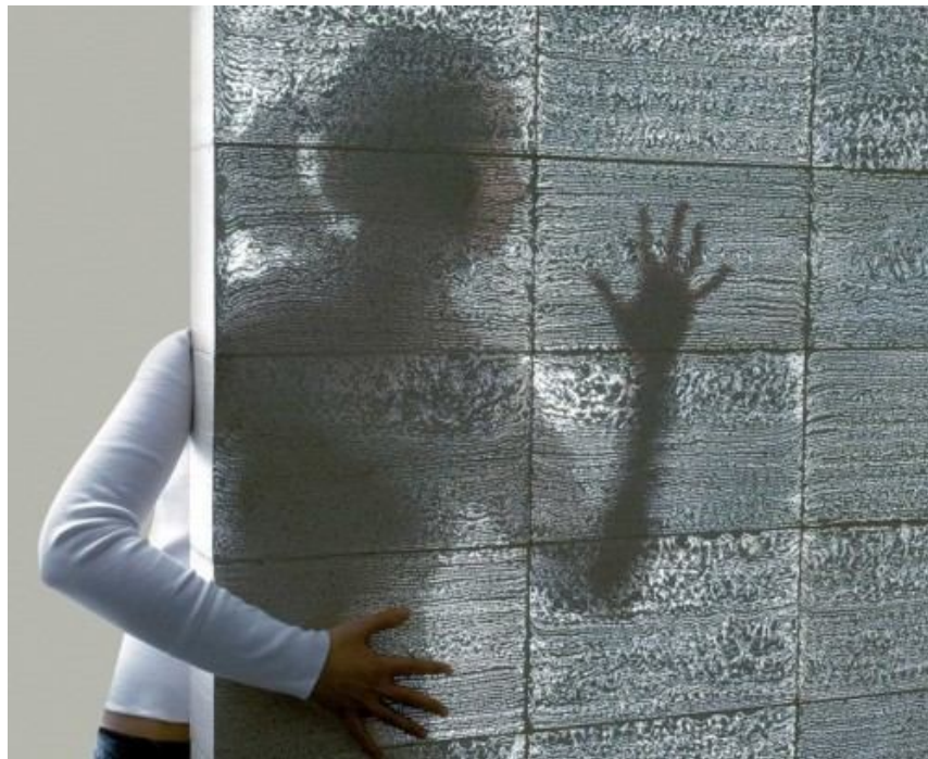
3.sz. kép LiTraCon-fal átlátszóságának szemléltetése
