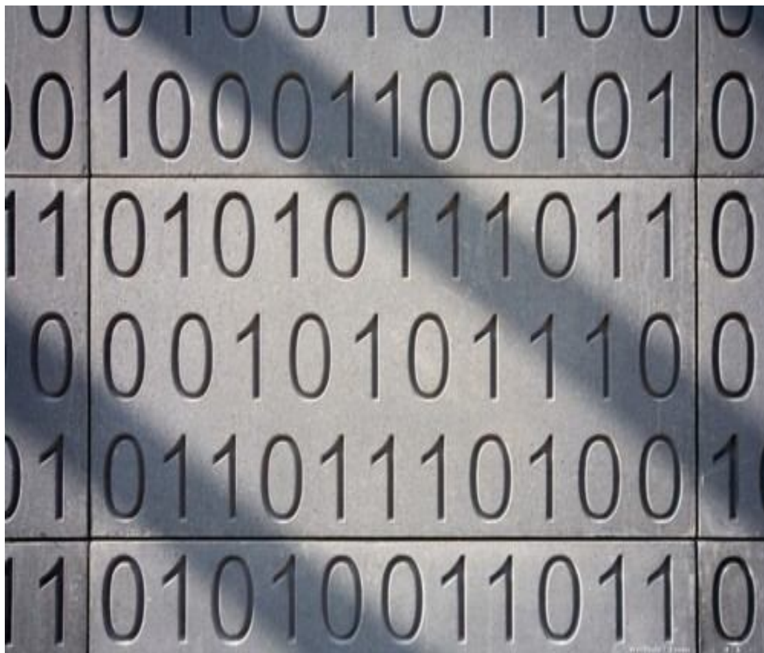
9.sz. kép Westside Essen irodaház homlokzata (vésett beton)
