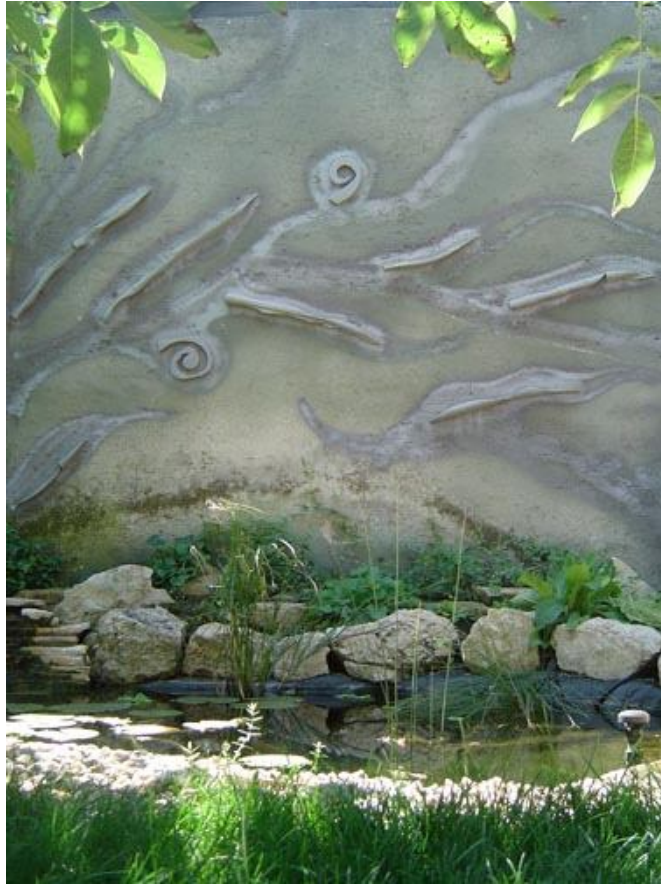
28.sz. kép Dekorbetonból készült tűzfal
