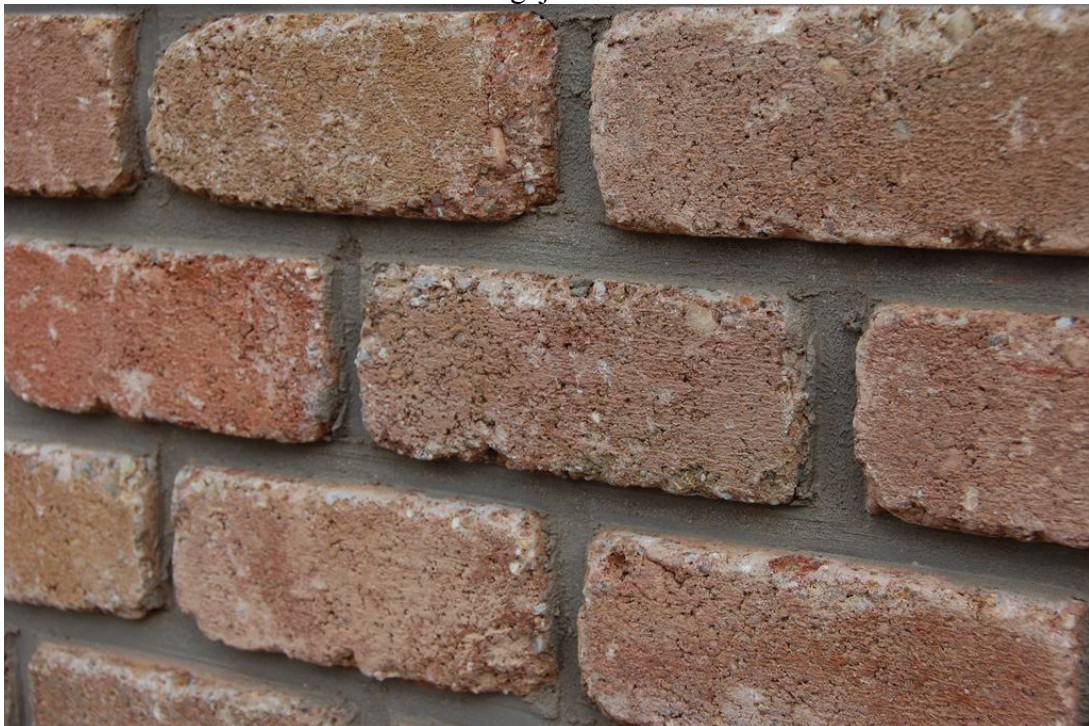
21.sz.kép Cementhabarcsba ágyazott téglakő falazat
