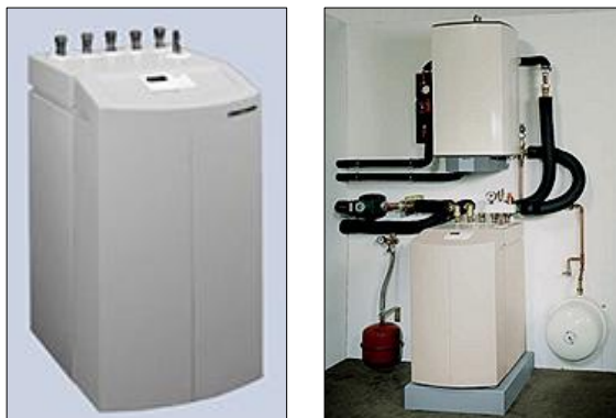
15. ábra Kompakt talajhő-víz hőszivattyú, és a fölé helyezett puffer-tároló (forrás: www.jagaber.hu )
