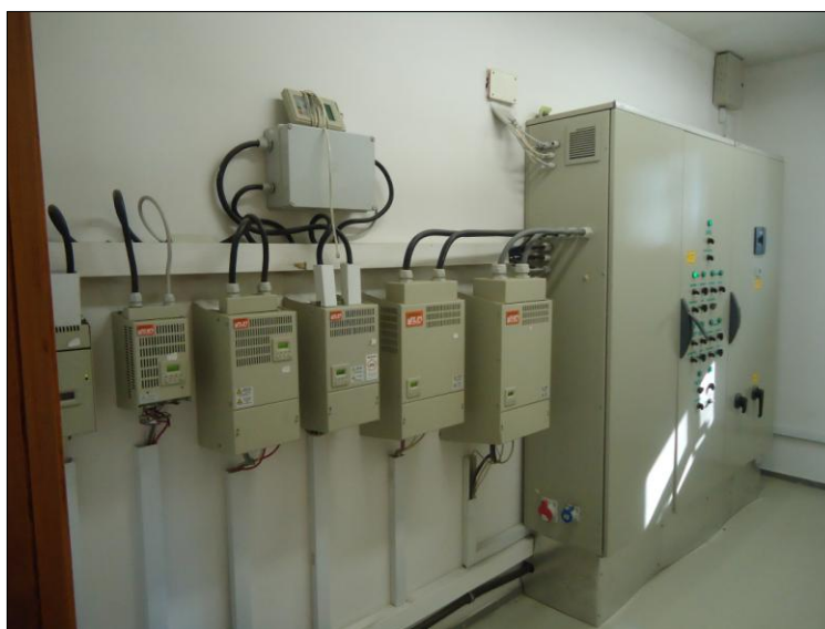
26. ábra Frekvenciaváltó berendezések (forrás: Veresegyház)
