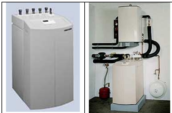
14. ábra Kompakt talajhő-víz hőszivattyú, és a fölé helyezett puffer-tároló (forrás: www.jagaber.hu )
