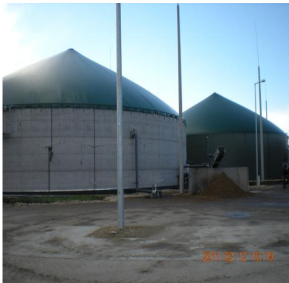
9.kép: erjesztett-anyag tároló és a szeperátor (Fotó: Hankovszky G., 2011)
