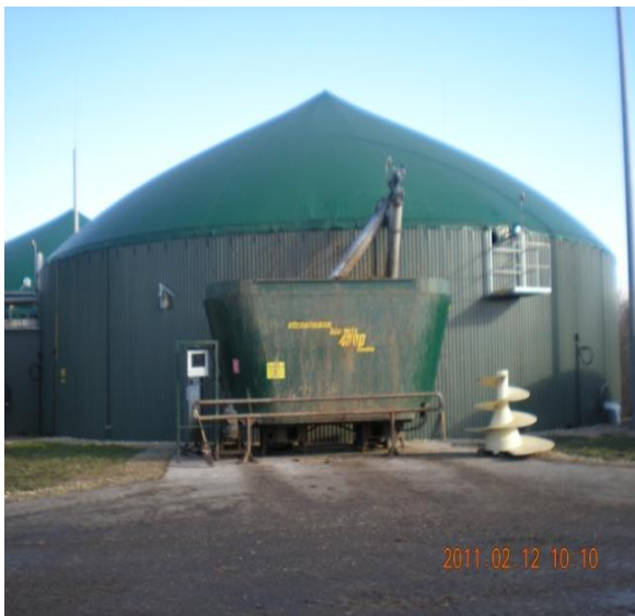
8.kép: előfermentor, szilárd alapanyag adagolóval (Fotó: Hankovszky G., 2011)
