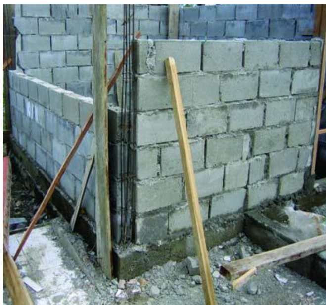
(27. ábra) zárt/merevített falazat
