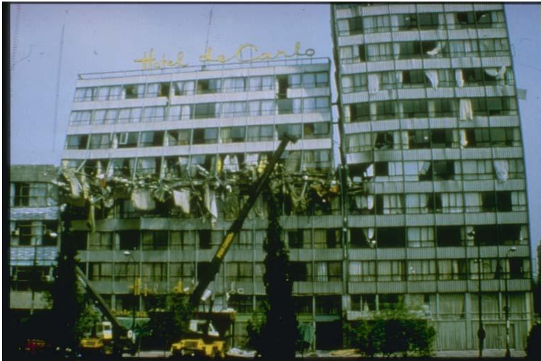
(52. ábra) puha szint nem csak a földszinten lehet
