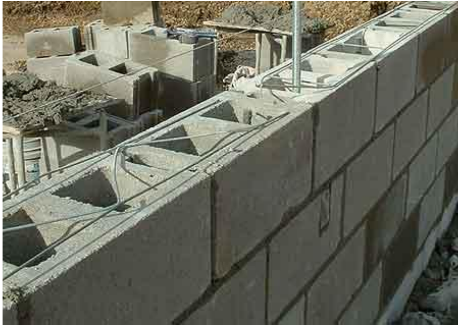
(26. ábra) erősített falazat
