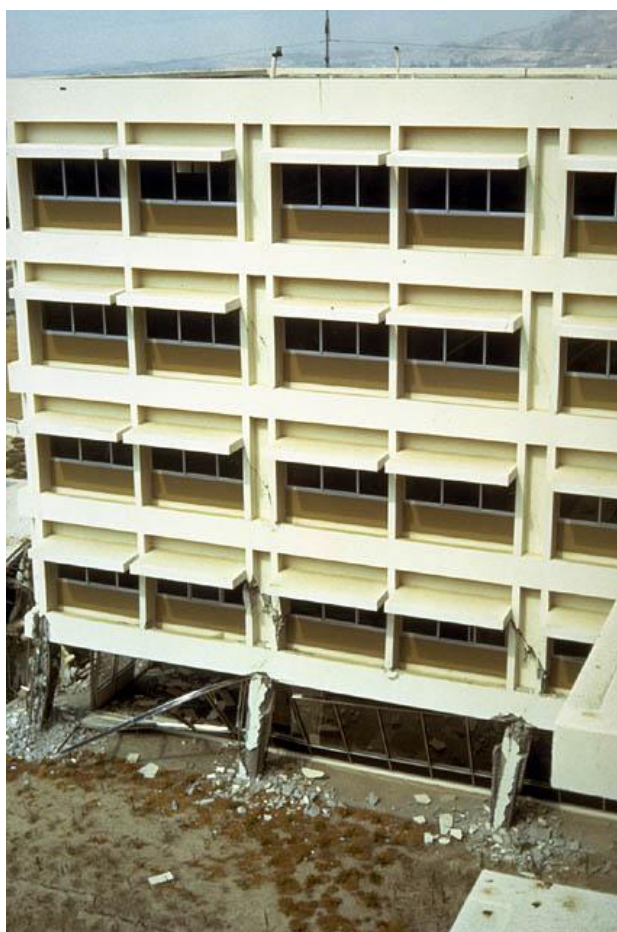
(51. ábra) a puha szint miatt súlyos károkat szenvedtek a földszinten levő pillérek. Jól látszik, hogy a felső szintek látszólag alig sérültek a rengés során
