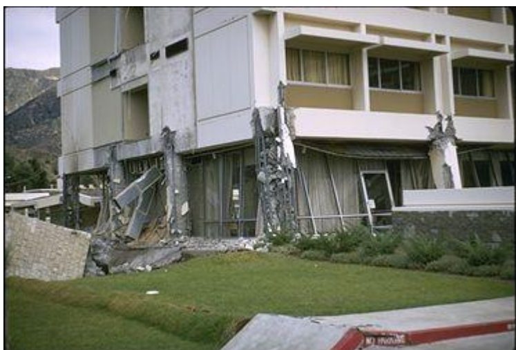
(43. ábra) a csavarás és a gyenge kengyelezés hatására a szélső oszlopok jelentősen sérültek
