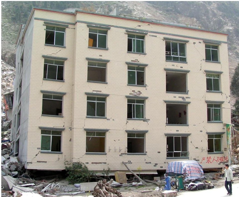
(53. ábra) a puha szint összeomlása után az épület felső része szinte sérülések nélkül megúsza a rengést
