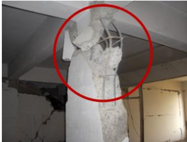
(34. ábra) gyengén kengyelezett, oszlop végen kialakult képlékeny csukló zónája
