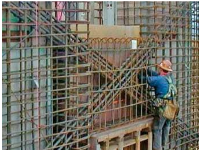
(29. ábra) kapcsolt merevítőfal és az összekötő gerenda vasalás kialakítása
