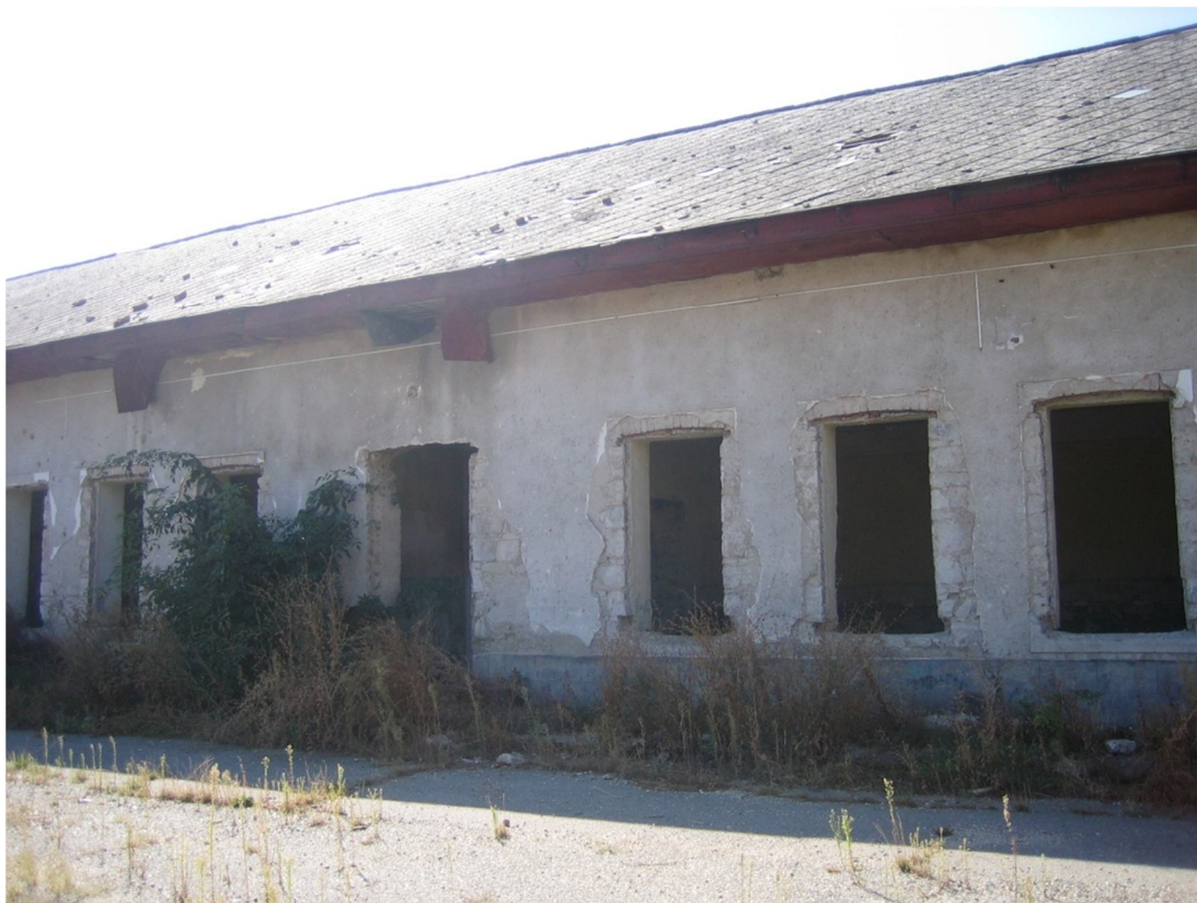
33. sz. melléklet: A Serház iskola épületének maradványai
