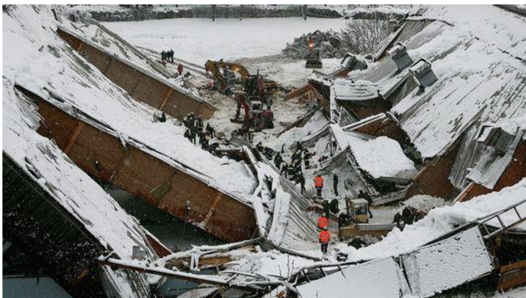
4. ábra: A Bad Reihenhall-ban összedőlt jégpálya
