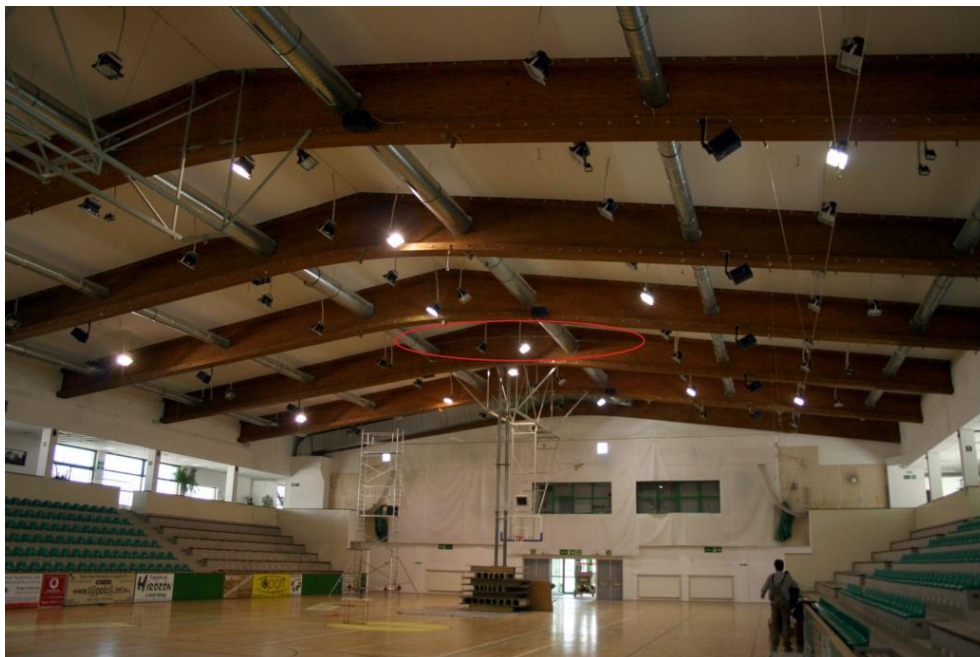
6. ábra: A tapolcai sportcsarnok és a tönkrement tartó alátámasztása,
