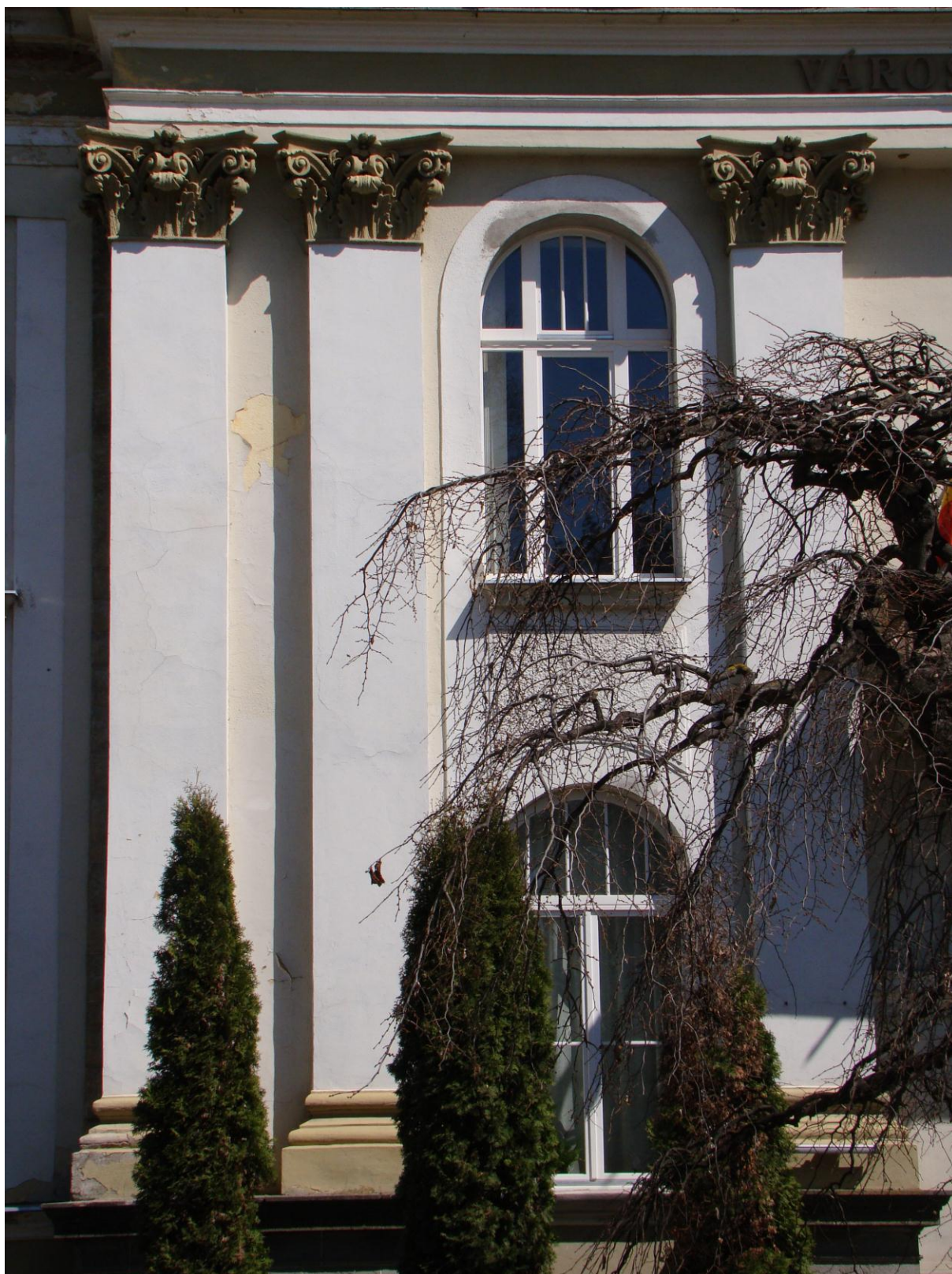
11. A főhomlokzat középrizalitjának pilaszterei
