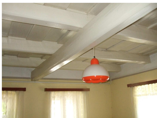
35. ábra: Látszó fa gerendafödém mestergerendával megerősítve
