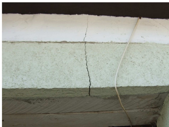
14. ábra: Szétnyíló függőleges repedés az ablak feletti áthidaló nagymértékű behajlása miatt (saját fotó)
