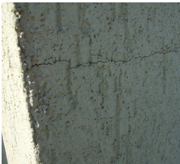
5. ábra: Az üvegezett tornác utcahomlokzati tartóoszlopán keletkezett vízszintes repedés az általaj süllyedése következtében (saját fotó)
