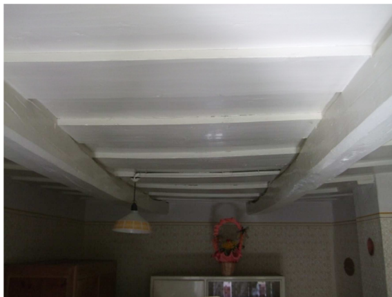
15. ábra: A fa gerendák behajlása a túlzott terhelés miatt (saját fotó)
