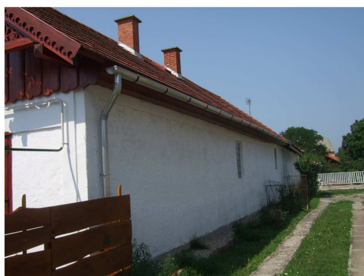
26. ábra: A szomszéd telek felőli homlokzat
