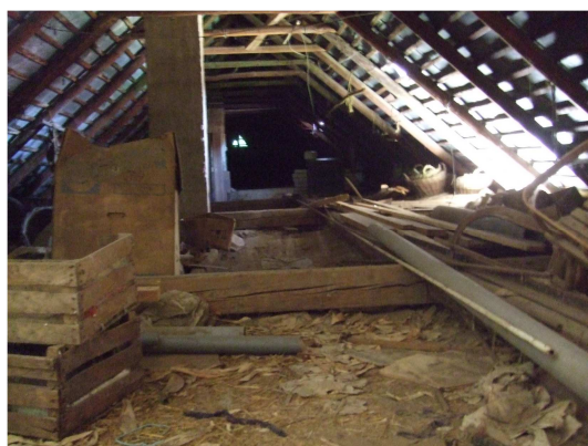
36. ábra: Torokgerendás fedélszék
