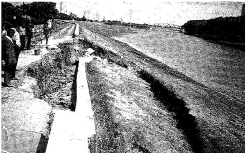
(2-5. kép): A töltéskorona elmozdulásai (Nagy L., 1985)
