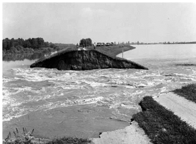
(2-1. kép): A Kettős-Körös jobb parti töltése Hosszúfoknál, néhány órával a töltésszakadás után (Nagy S., 2010)
