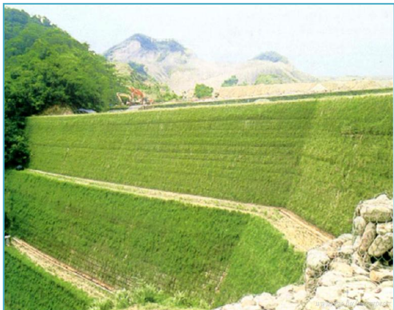
1. ábra: Georácscsal erősített talajtámfal (Szendefy, 2012b)
