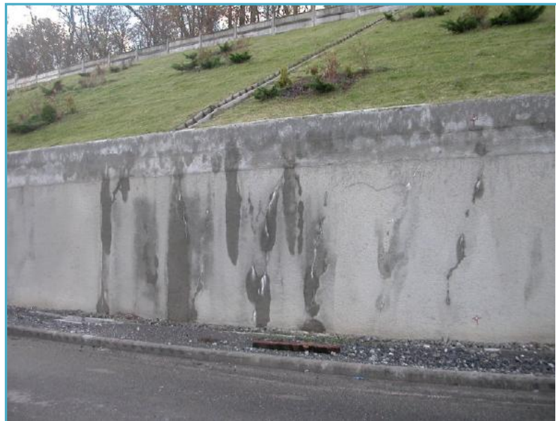
4. ábra: Résfal autópálya mentén, kevésbé esztétikus megjelenés (Czap, 2011b)
