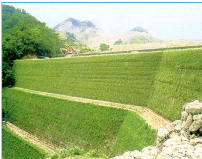
1. ábra: Georáccsal erősített talajtámfal (Szendefy, 2012b)
