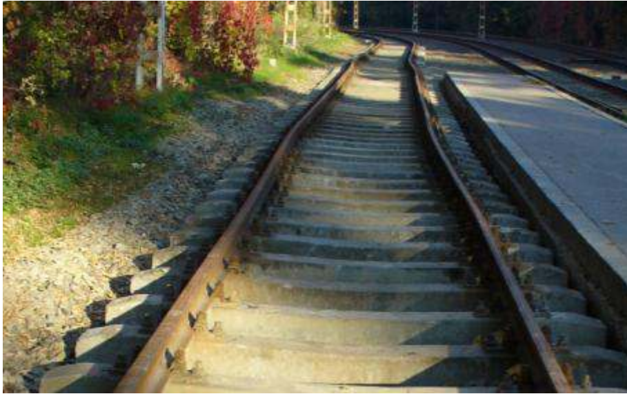
2. Fénykép: A 41-es villamos vonalán építés alatti „LM” jelű vasbeton aljas felépítmény
