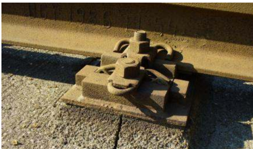
3. Fénykép: A Budapesti 14-es villamos Pozsonyi utcai felüljáró ragasztott felépítménye
