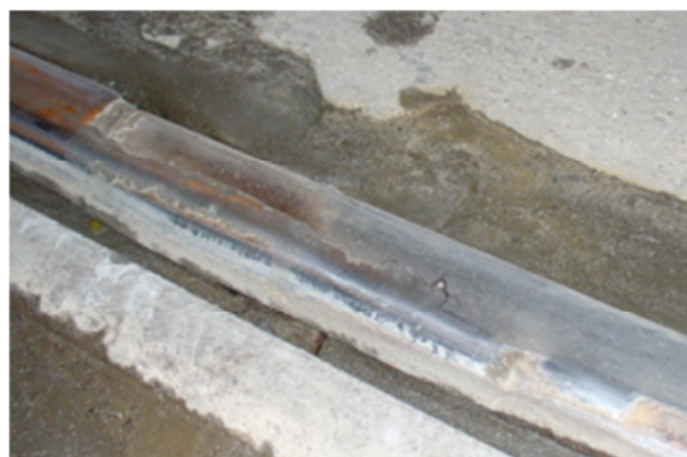
9. ábra: Felépítményváltás Szent Gellért tér (sínfej felhegesztése két oldalról)
