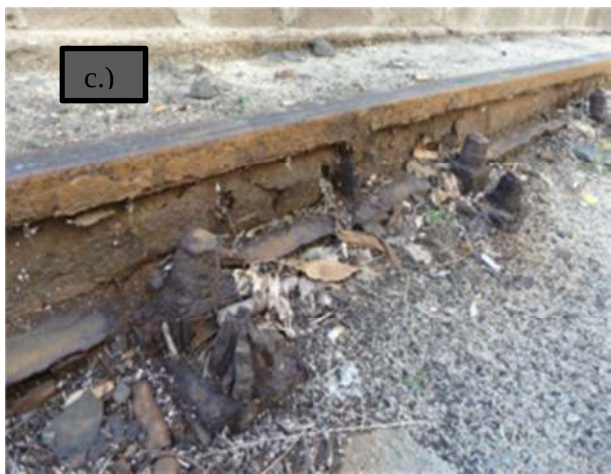
11. Fényképek: Sínszálak jelentős korróziója
