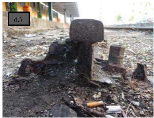
11. Fényképek: Sínszálak jelentős korróziója
