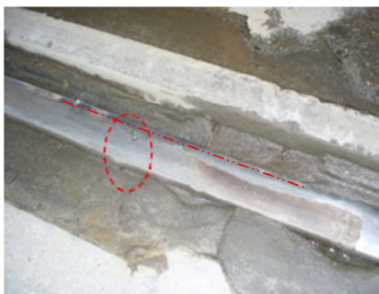
9. ábra: Felépítményváltás Szent Gellért tér (sínfej felhegesztése két oldalról)
