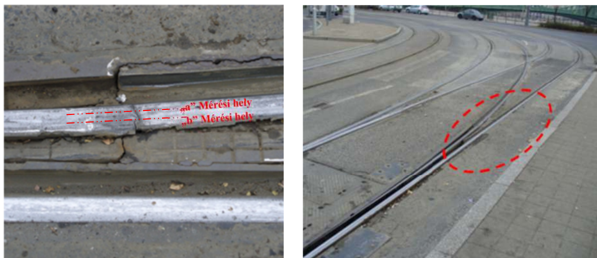
1. ábra: Csúcsín hegesztésének törése a Szent Gellért téren
