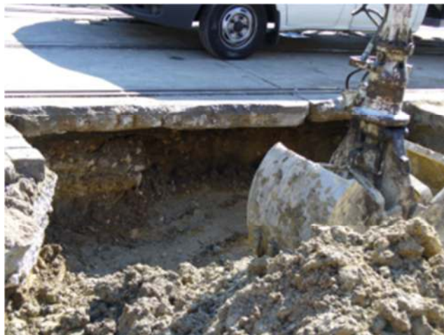
14. Fénykép: Közmű meghiúsodás okozta tönkremenetel
