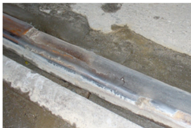
5. ábra: Felépítményváltás Szent Gellért tér (sínfej felhegesztése két oldalról)
