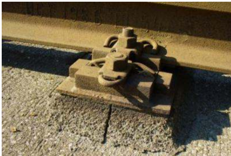
4. Fénykép: A Budapesti 14-es villamos Pozsonyi utcai felüljáró ragasztott felépítménye
