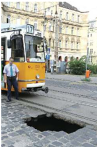
14. Fénykép: Közmű meghibásodás okozta tönkremenetel
