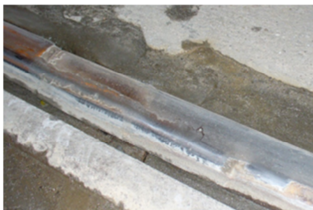
GK4. ábra: Felépítményváltás Szent Gellért tér (sínfej felhegesztése két oldalról)
