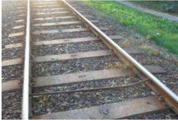
1. Fénykép: „U” jelű lágy vasbetétes betonalj a 41-es villamos vonalán
