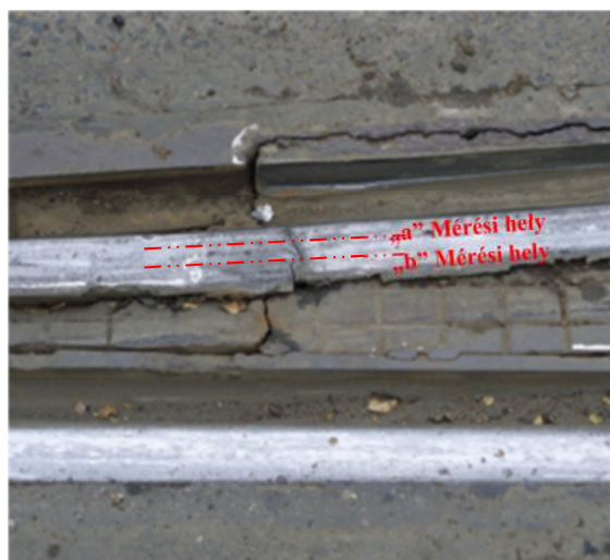
GD1. ábra: Csúcsín hegesztésének törése a Szent Gellért téren és a hozzátartozó mérési grafikonok
