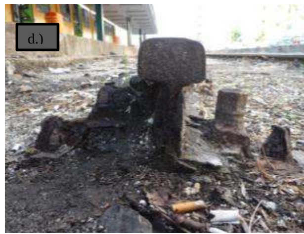
13. Fénykép: Sínszálak jelentős korróziója
