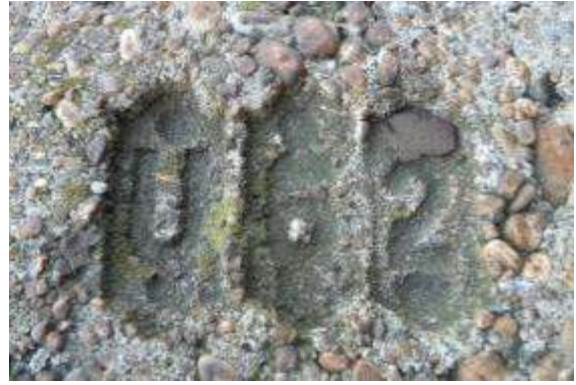
1. Fénykép: „U” jelű lágy vasbetétes betonalj a 41-es villamos vonalán
