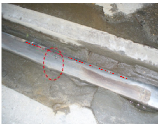
GK4. ábra: Felépítményváltás Szent Gellért tér (sínfej felhegesztése két oldalról)
