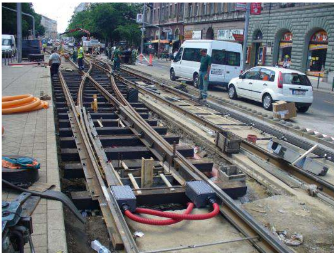
3. Fénykép: Talpfa alkalmazása burkolt kitérőben (Corvin-negyed megálló 4,6-os villamos)
