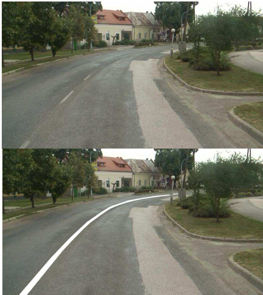
15. ábra - 20+208 szelvényénél történt baleset és a javaslat kivitelezése
