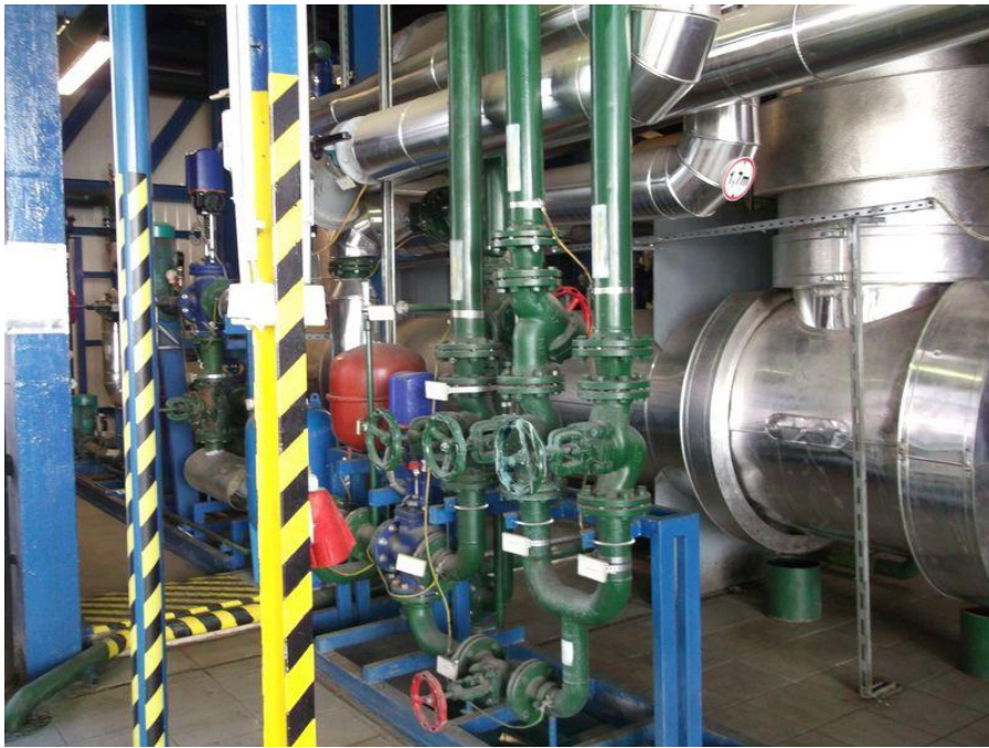
31. ábra A füstgáz-hőcserélők kívülről
