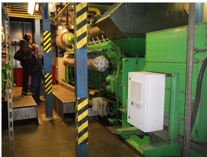
26. ábra Az egyik húzhengeres gázmotor a generátor felől
