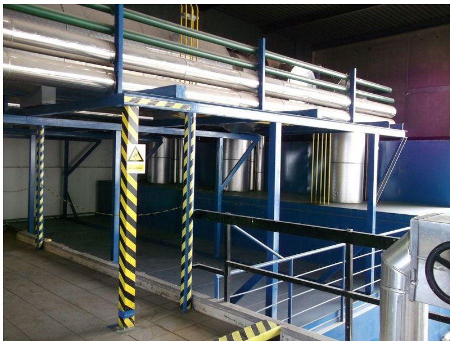
30. ábra A füstgáz elvezetése a füstgáz-hőcserélőkre
