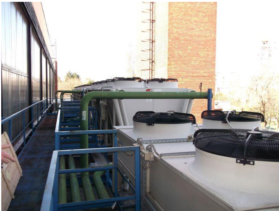
29. ábra A kényszerhűtők és a turbóhűtő
