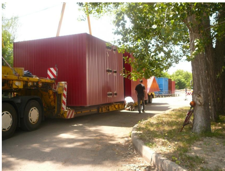
1. kép: Nagyteljesítményű kazán szállítása három részre bontva
