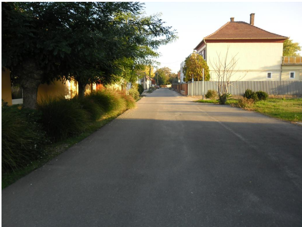
5. melléklet: A felújított Vasváry P. utca
