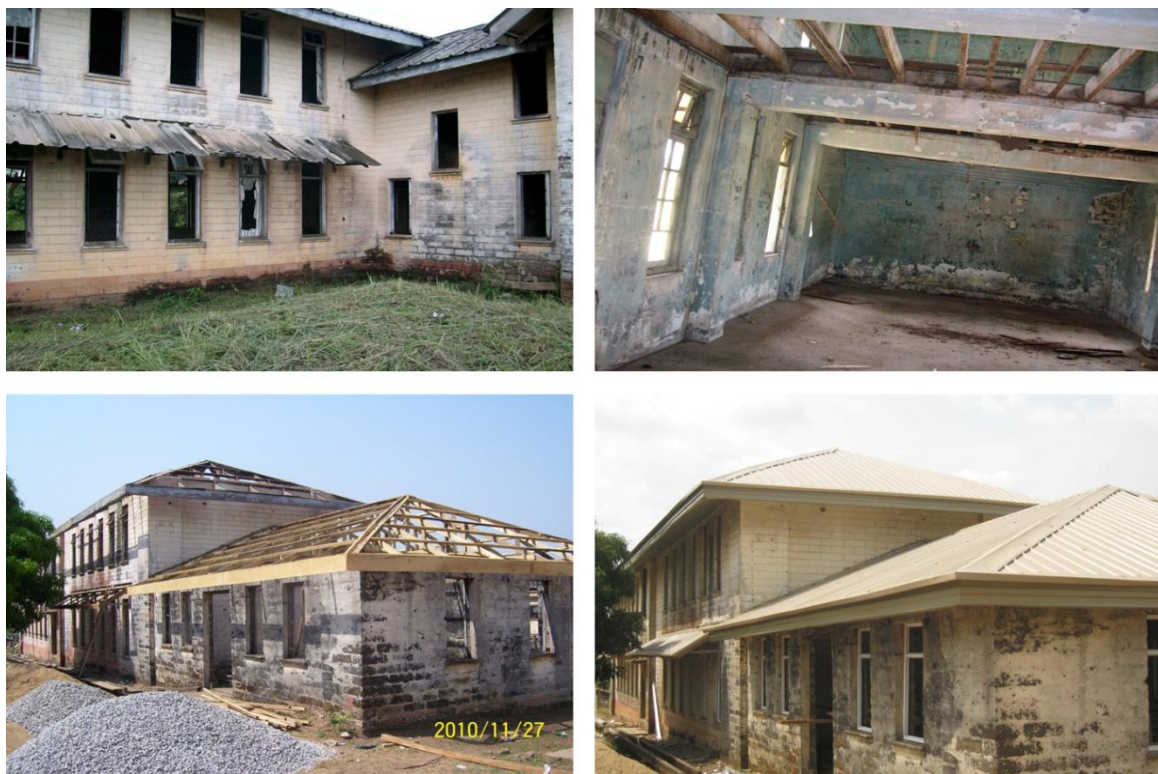
5. kép: A School House épület átépítése és felújítása (folyamatban)
