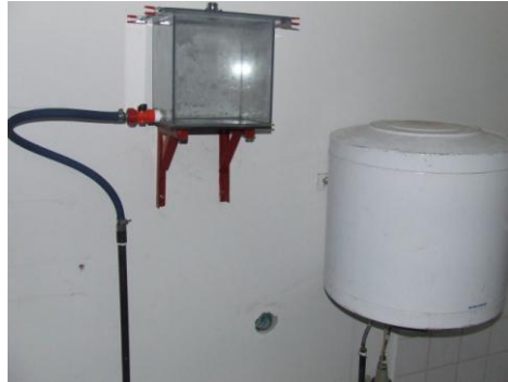
4.2.3. ábra. A kiegyenlítő tartály helye a bojlerhez képest.
