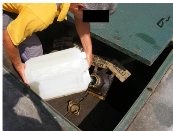
16. ábra az üres váltásra levételre került üzemanyag visszatöltése a tartályába
