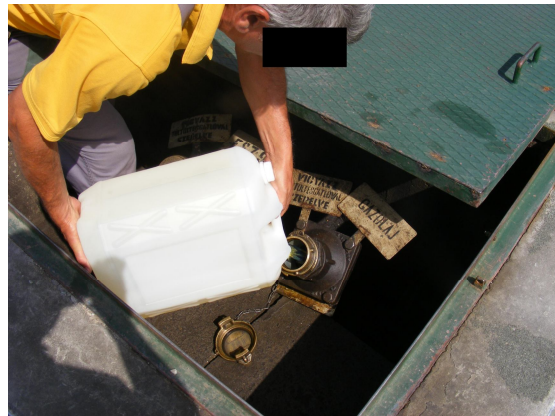
16. ábra az üres váltásra levételre került üzemanyag visszatöltése a tartályába
