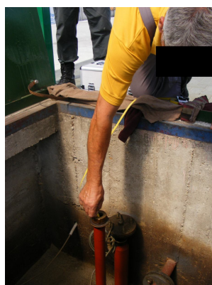
13. ábra a függőónos lécelés eljárásának lépései
