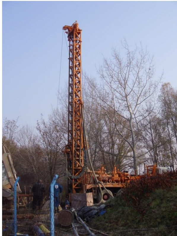
1. kép - Fúróberendezés (saját kép, 2011)
