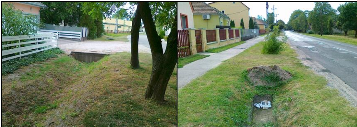
9. ábra. Kocsifeljárók és virágágyások miatt az árkok kapcsolata hiányos, a túlfolyó víz pedig a garázsokba, pincékbe áramlik, vagy az úttestet mossa alá. (A szerző fotói.)
