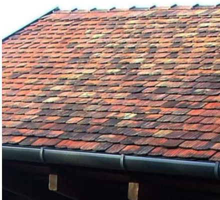
18. kép: bontott cserép héjazat
