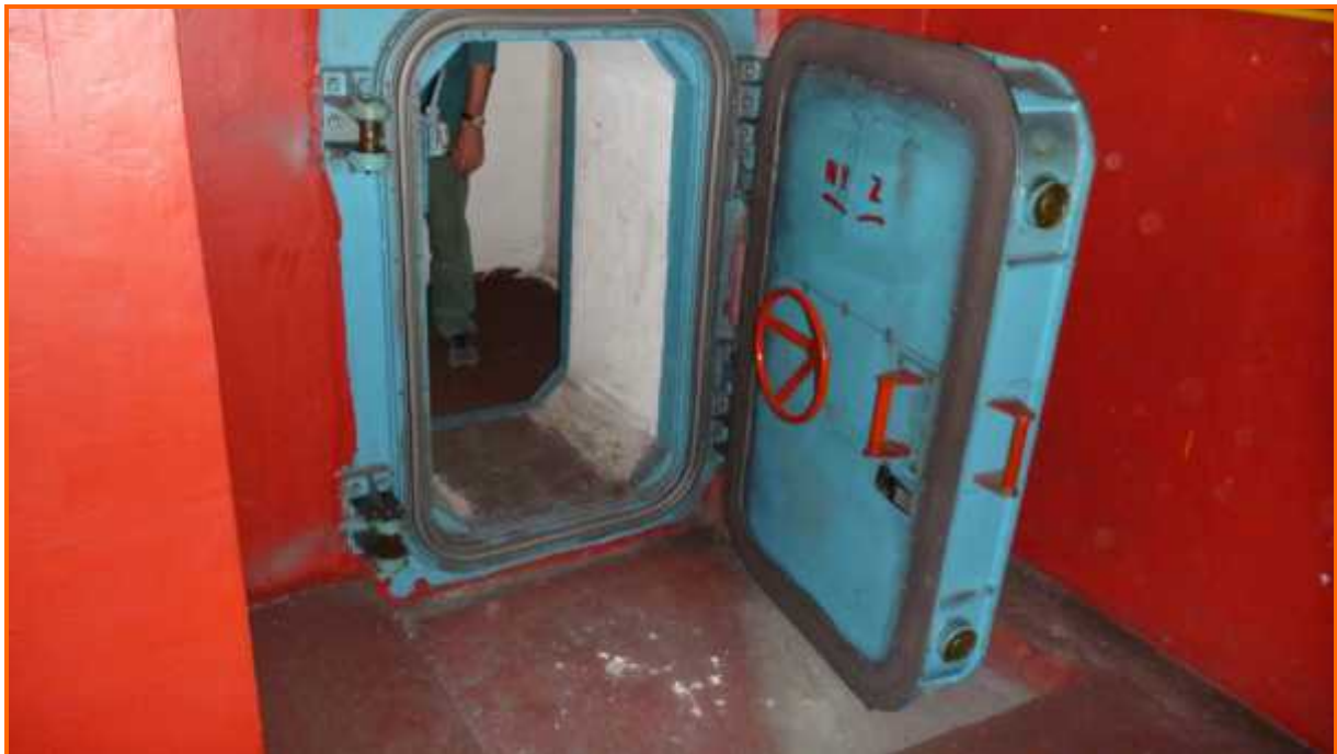
9. ábra Kézi működtetésű zsilip kapu Forrás: szerző felvétele
