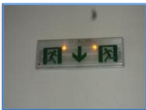
6 – 7. kép: menekülési útvonalat jelző és riasztási fényjelző berendezések
