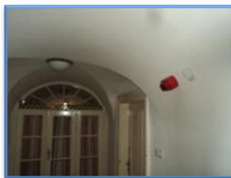
6 – 7. kép: menekülési útvonalat jelző és riasztási fényjelző berendezések
