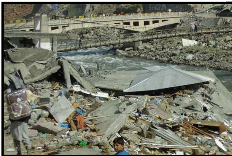
11. számú ábra: A 2005. év októberi Kasmíri földrengés pusztítása
