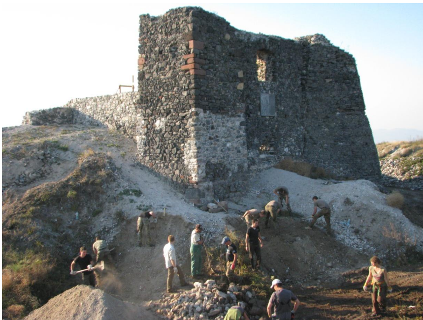
13-as számú kép: Felújítási munkálatok közben, 2012. október.
