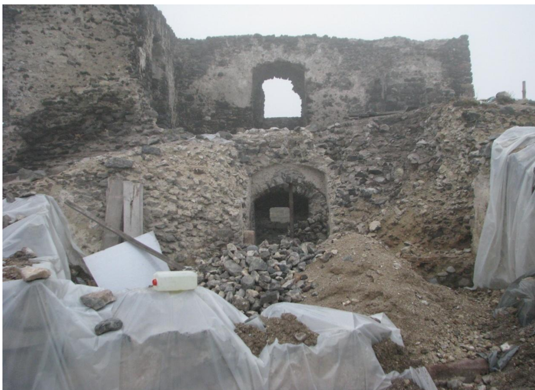
17-es számú kép: Az Öregtorony munkálatok közben, falazás előtt, 2011 decemberében.
