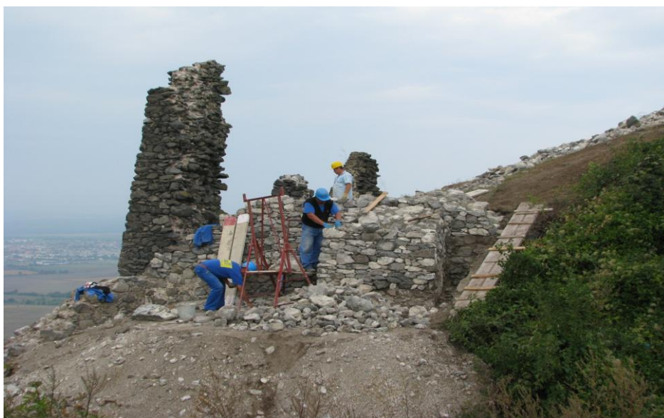
14-es számú kép: A délnyugati falsarok felújítása.
