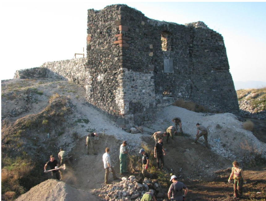
13-as számú kép: Felújítási munkálatok közben, 2012. október.
