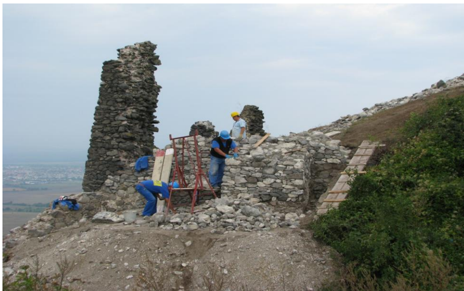
14-es számú kép: A délnyugati falsarok felújítása.
