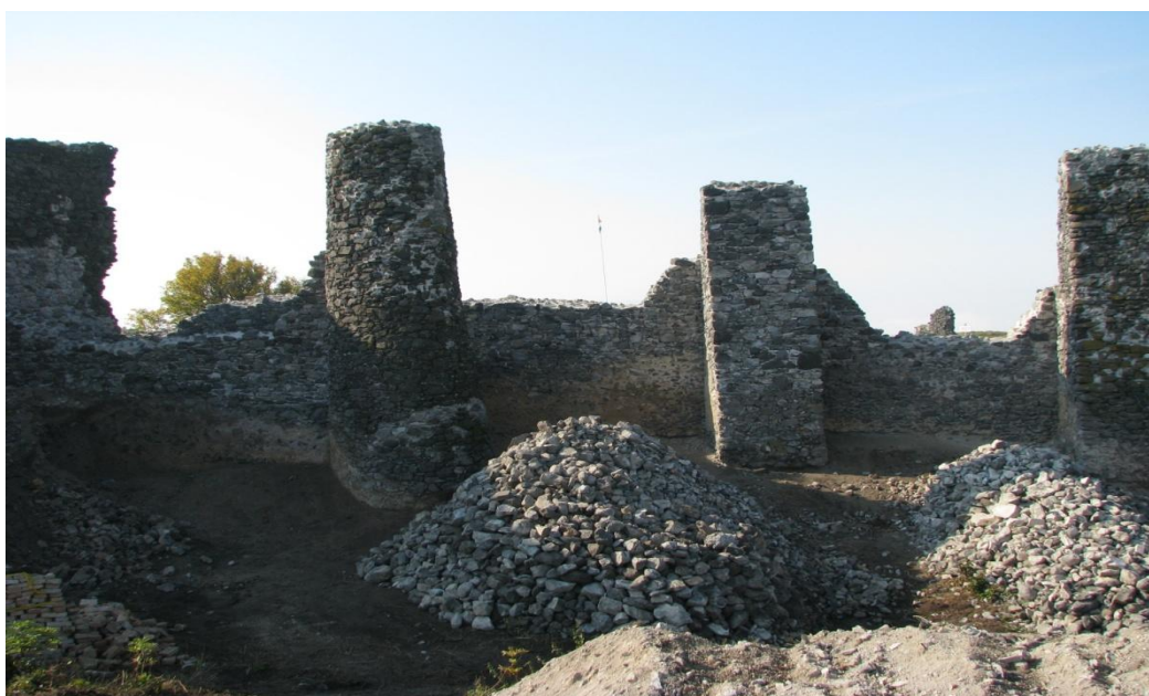
12-es számú kép: 2008-ban a keleti falszakasz felújítása látható. Támpillérekre ráhúzták a falakat.
