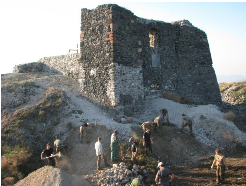
13-as számú kép: Felújítási munkálatok közben, 2012. október.
