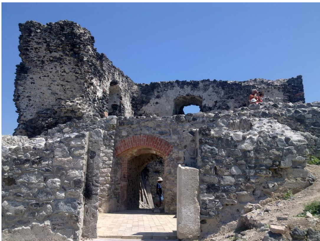
18-as számú kép: Munkálatok-, falazás után. 2012 nyara.
