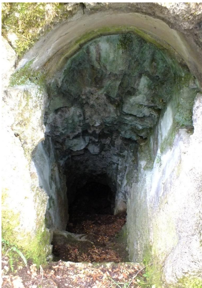
25. kép: A Cima 2 tetején található kaverna részben elzáródott bejárata. Az üreg belsejébe egy kibetonozott bunkerből lehet lejutni.
