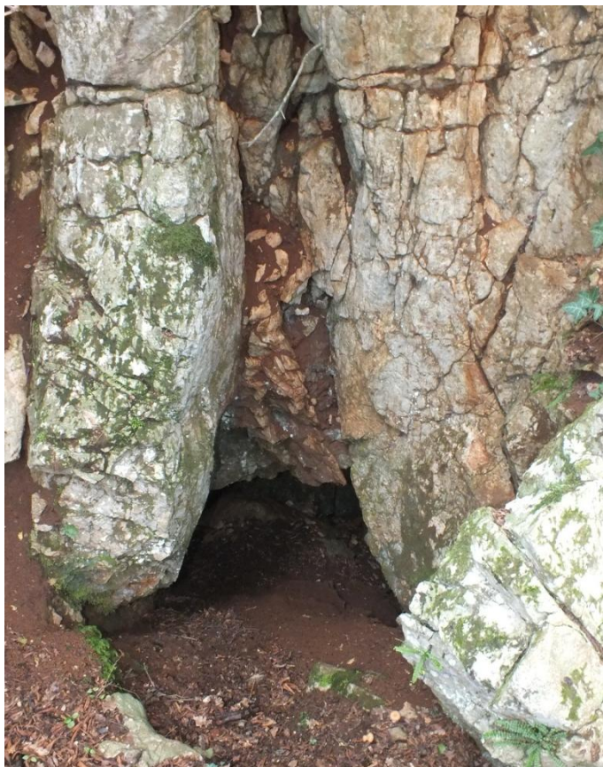
21. kép: Vetőbreccsa leomlása miatt elzáródott kavernabejárat (4. rajz) a Schönburgtunnel déli bejáratától kb. 150m-re északnyugati irányban.
