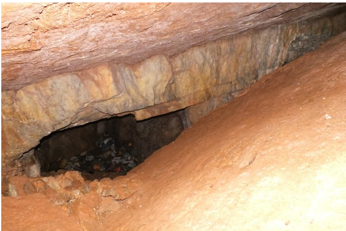
23. kép: A San Martino del Carso falu alatt található mesterséges honvédkavernában egy leszakadt réteglap zárja el a járatok nagy részét.
