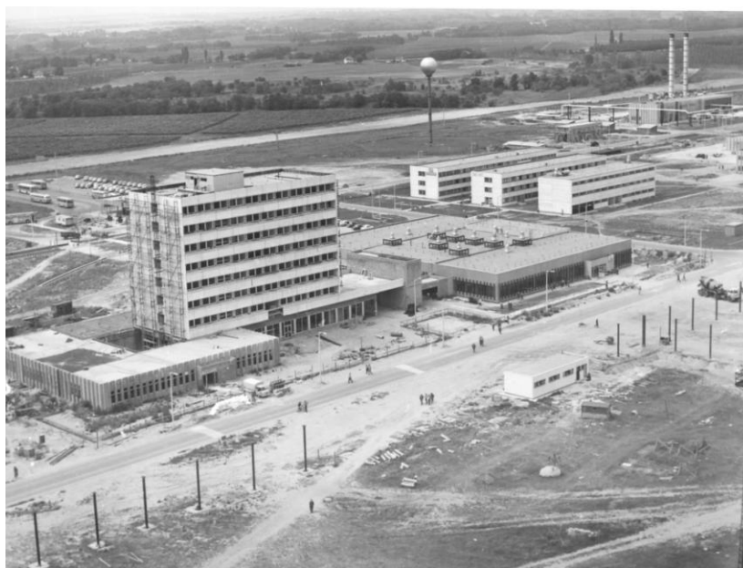
A főépület építése
