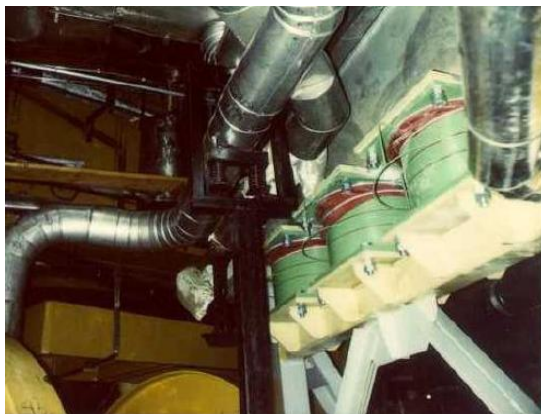
7. sz. ábra: A viszkózus lengéscsillapítók a gőzfejlesztők alatt
