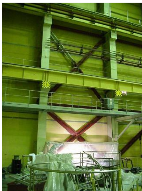
8. sz. ábra: Hosszirányú megerősítések a reaktorcsarnokban
