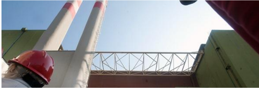
9. sz. ábra: A hídszerkezet a lokalizációs tornyok között a reaktorcsarnok szerkezetének megerősítésére
