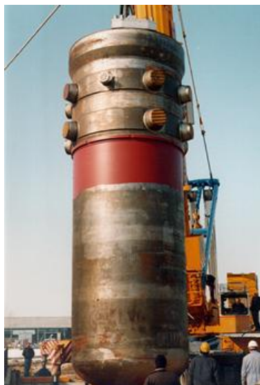
4. sz. ábra: A reaktortartály
