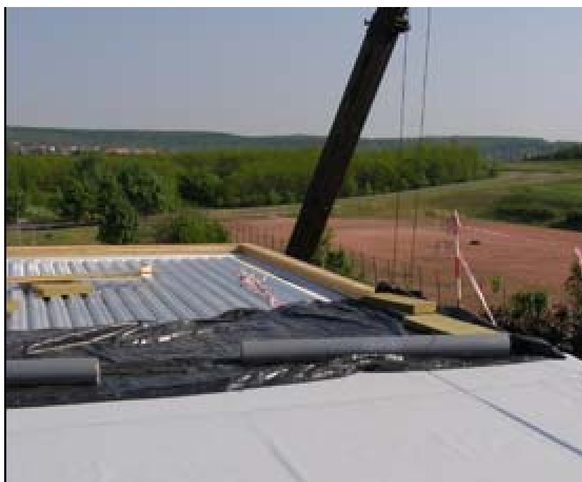
4.8. ábra. A tetőrendszer szigetelése (MTOK, 2012)
