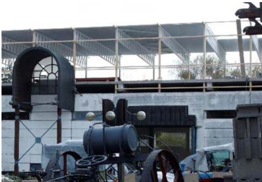
4.7. ábra. A trapézlemez elhelyezése az acélszelemeneken (MTOK, 2012)
