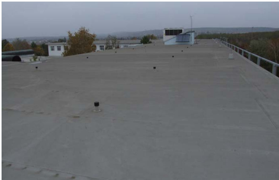
4.9. ábra. A fotovillamos modulok elhelyezésére szolgáló tetőfelület
